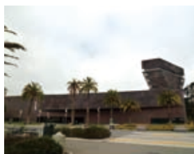
デ・ヤング美術館 (銅の外壁)
