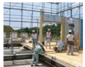
国立極地研究所での仮組み立て作業
