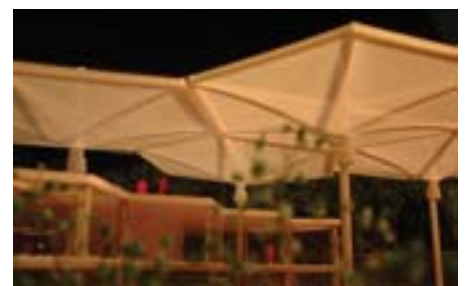
屋根部見上げ
