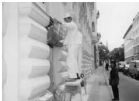
モルタル外壁の補修工事
