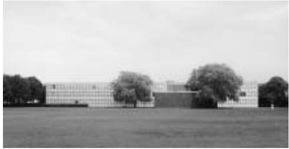
デンマーク：ロードブレ市庁舎 (A. ヤコブセン)
