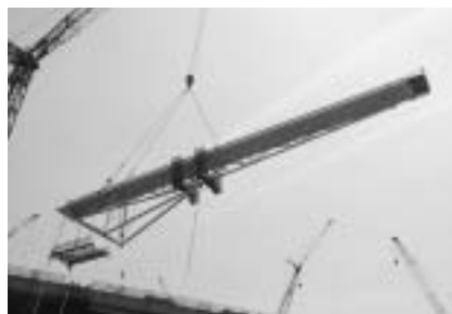
トラス架構の吊上げ建方
