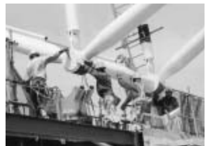
トラス架構をピン支承にセットする
