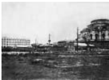
震災直後の駿河台。右はドームの落ちたニコライ堂。左手の白亜の建物は日本大学駿河台校舎。
