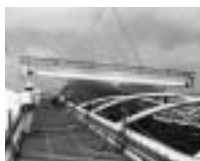
膜パネルの 展張工事
