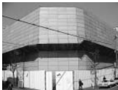
解体養生中の旧1号館
