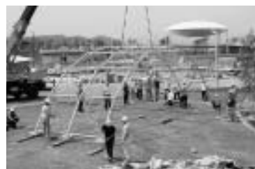
施工中のテンセグリック・トラス・アーチ
