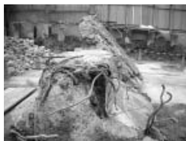
基礎コンクリート塊
