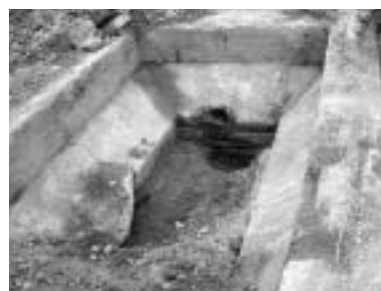
基礎フーチング
