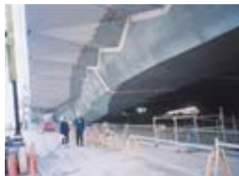
大さん橋国際客船ターミナル工事現場
