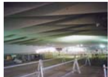
客船ターミナル現場の工事内部
