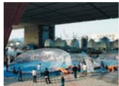
インフレーション作業(少しの風でも大きく揺らぐ)
