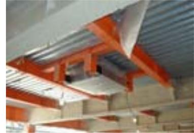
床振動を抑制するTMD制振装置
