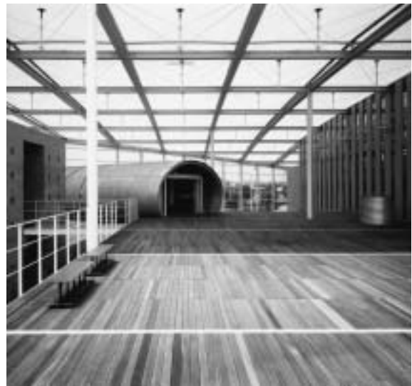
マルチホールの西側全景、半外部空間化され多様な利用が意図されている
