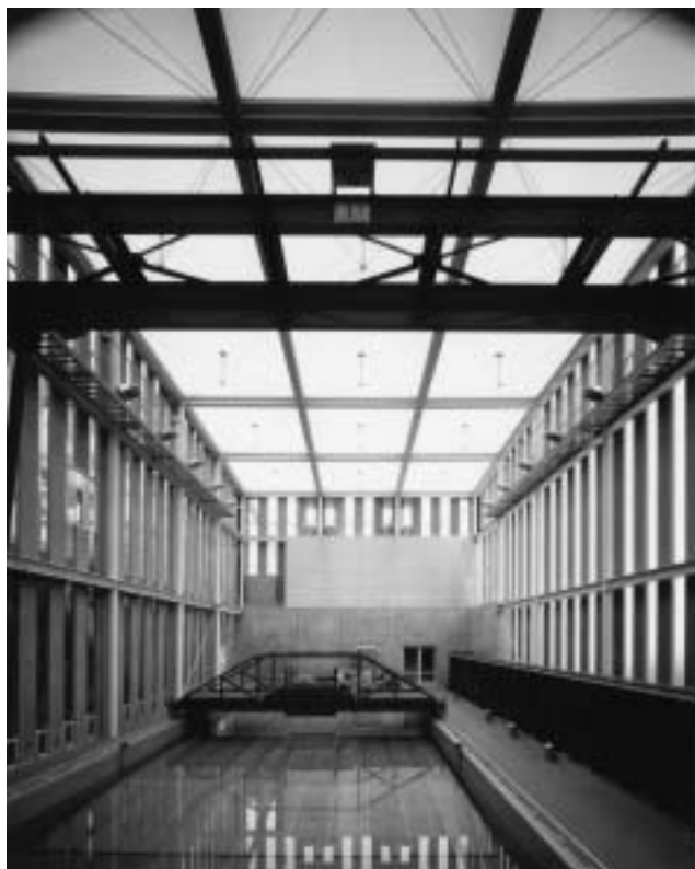
水槽実験室、自然の光と風が快適・安全な実験環境をつくり出す
