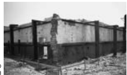
改修前の煉瓦壁北東角
