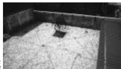
再生煉瓦を敷き詰めた中庭
