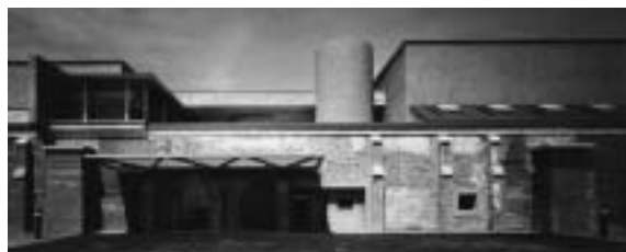
改修後の東側通用口廻り
