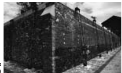
改修後の自立煉瓦壁北東角
