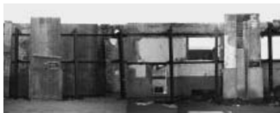
改修前の東側通用口廻り
