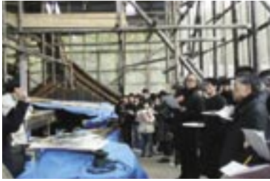
大徳寺玉林院修復現場（京都） 関西大学の永井 規男先生に解説していただいている
