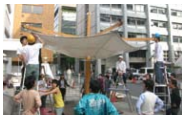
テンセグリック・アンブレラの施工の様子
