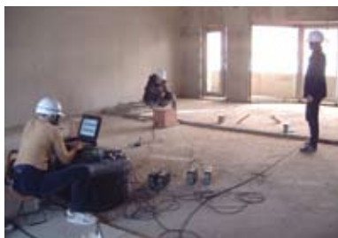
施工中物件での床スラブの振動測定の様子 (井上研究室の学生の方々にご協力いただきました)
