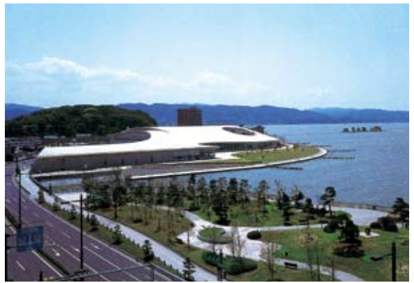
島根県立美術館（左写真・鉄骨工事）
