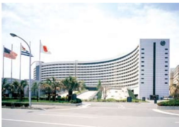
作業所長を務めた最後の「現場」シェラトングランデトーキョーベイホテル（1988年3月30日竣工）
