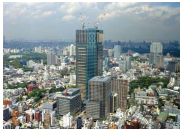
東京ミッドタウン 工事状況
