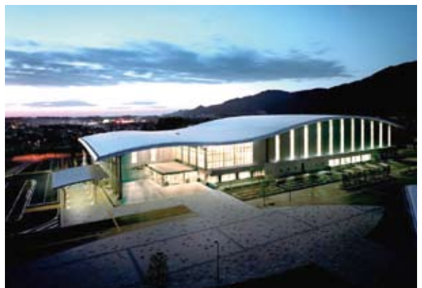
島根県立浜山体育館（左写真・鉄骨工事）
