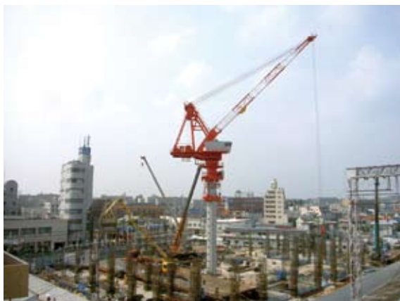
小田急相模原駅北口再開発事業の中核となる4階に免震装置がある駅ビル(上部は分譲住宅)。平成20年春には、写真のA地区が完成する。
