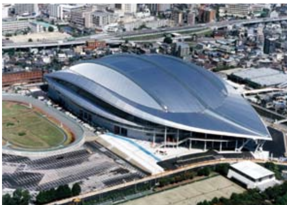
競輪のヘルメットをモチーフにした北九州メディアドームの屋根
