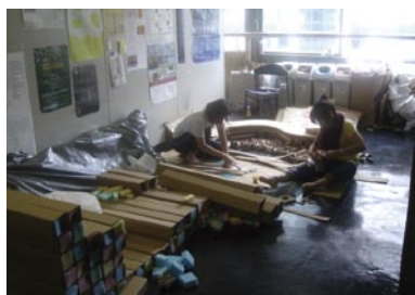
EVホール前での製作風景
