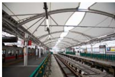
東急東横線元住吉駅 竣工後に現場に足を運ぶのも楽しみのひとつです
