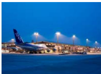
成田空港第1旅客ターミナルビル第5サテライト新築工事
