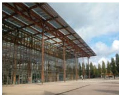
5. Mont-Cenis Academy / Herne 間口70m、奥行170m、高さ16mの巨大なボックスの中に宿泊、研修施設などが組み込まれている
