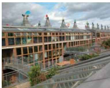
6. Beddington Zero Energy Development / London 屋根の上の巨大なウインドカル（回転換気塔）が景観を特徴づけている
