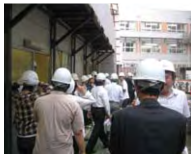
日本大学櫻丘高等学校新校舎新築工事現場(Iコース)
