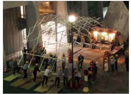
リフトアップされるエントランスドーム
