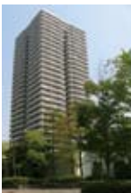
パークシティ新川崎 (わが国初の高強度コンクリート)
