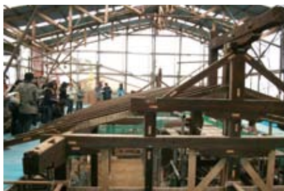
清水寺馬駐修理現場
