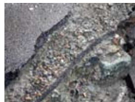
礫と粘性土が混在する表層地盤 (Bergen)
