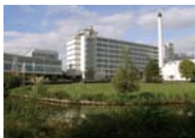
ファン・ネレ工場 （左）外観 （右）内観： オフィス部分。インテリアに箱を挿入することで図られた空間の透明性の維持と執務環境としての機能性の具現。
