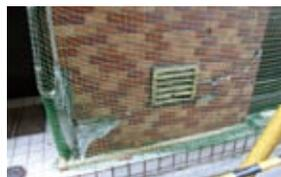
RC造柱のタイルの剥落
