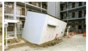
液状化で沈下した集合住宅内倉庫
