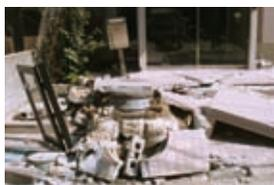
浄化槽の浮き上がり（船橋市）
