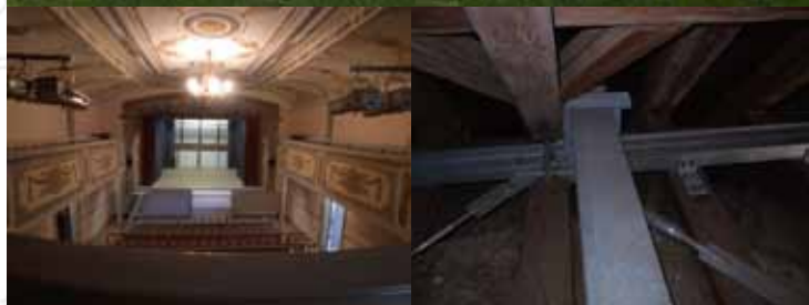
上：ヴァイセンホルン市立劇場。かつて市壁があったところは取り壊され公園となっている。階段は避難用にその後つくられたもの。左下：客席から舞台を見る。右下：1997年に大掛かりな修復が行われた。写真は補強された鉄骨の梁や水平ブレース。
