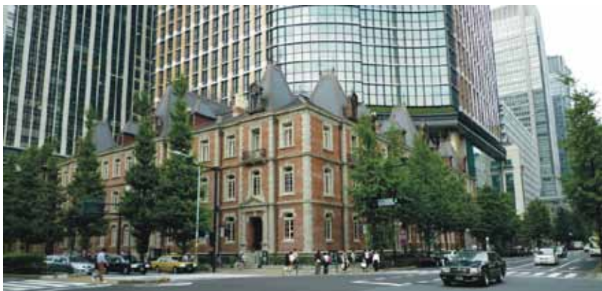
事例のひとつとして研究対象となった「三菱1号館美術館」
