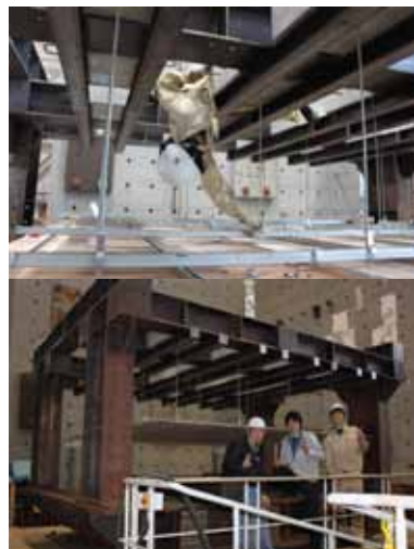
上：吊り天井中央のボルトを止める作業時の写真。 下：大きな試験体が完成。メンバーで記念写真を撮る。
