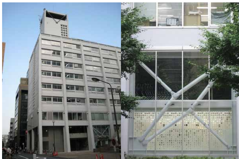
「日本大学理工学部駿河台校舎5号館」。築50年以上の建物を中間階(3階)で免震改修し再生させた。BELCA賞受賞。(改修設計:日本大学理工学部駿河台校舎5号館改修検討委員会+清水建設)
