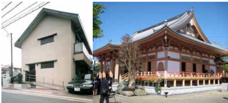
左：免震化した戸建て住宅。（構造設計：古橋剛） 右：伝統木造工法の寺院「常楽院」を最新の技術で免震化して建設した。（免震構造設計：古橋剛）
