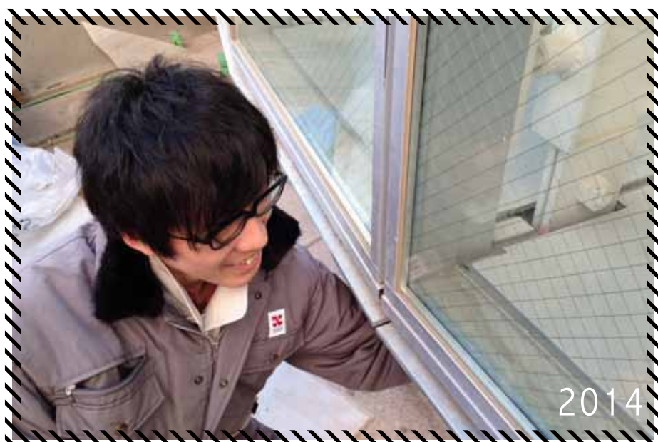
現場でカーテンウォールの取り付けを確認しているところ。
