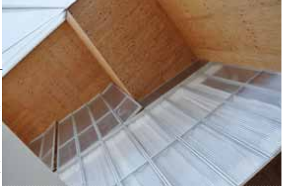
作業場 1 から見上げる
