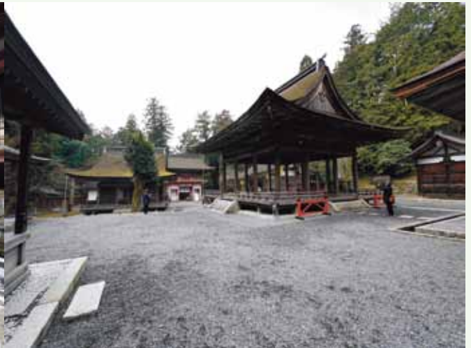
日吉大社東宮。各建物の向きと配置の軸線が微妙にずらされている。緩やかな傾斜の敷地に合わせるように配置される建築群とその環境が美しい。
