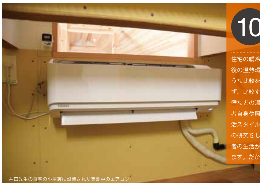
井口先生の自宅の小屋裏に設置された実測中のエアコン
