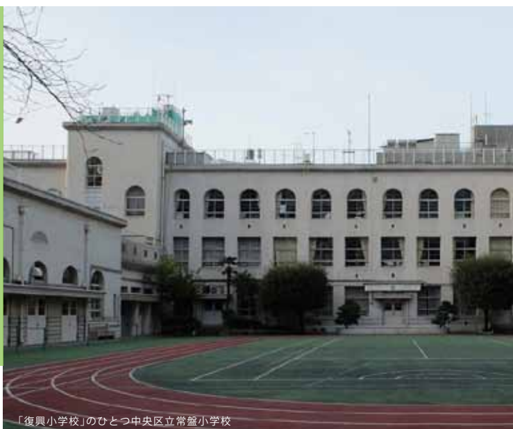
「復興小学校」のひとつ中央区立常盤小学校
