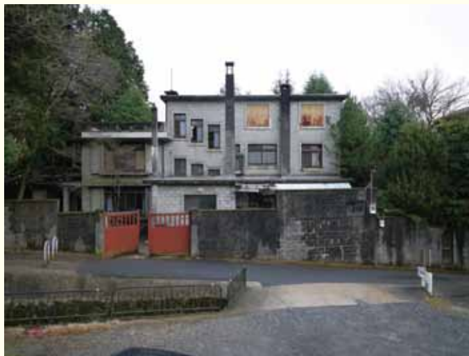
旧鶴巻邸。当時最先端の工法「中村鎮式コンクリート・ブロック構造」による造形の可能性を追求した作品。
