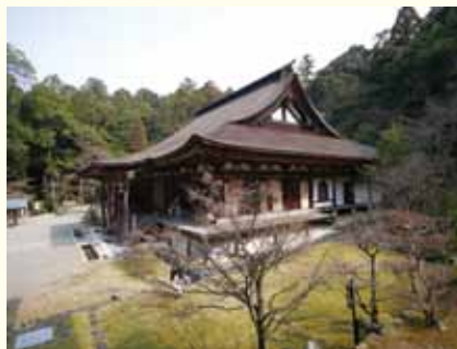
左：西明寺本堂。鎌倉時代に5間堂として建立され、南北朝時代に部材を移動・転用して7間堂に改造された。右：東寺築地塀。現在修理工事中の塀の断面。築地塀の内側の構造がどのようにになっているかは、修理工事時の調査ではじめてわかる。
