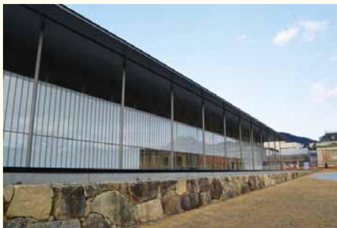
京都国立博物館平成知新館。既存の本館や周囲の社寺との軸線、発掘された遺跡の痕跡を示すデザインなど、過去と現代との融合が随処に工夫されている。
