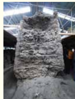
左：西明寺本堂。鎌倉時代に5間堂として建立され、南北朝時代に部材を移動・転用して7間堂に改造された。右：東寺築地塀。現在修理工事中の塀の断面。築地塀の内側の構造がどのようにになっているかは、修理工事時の調査ではじめてわかる。
