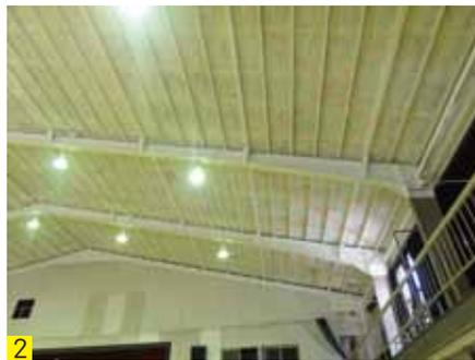
写真1：A小学校体育館。平鋼ブレースの構面外残留変形が目で見てもはっきりわかるほどに大きい。ブレースの構面外変形が非常に大きかったために、ボルトの先端が壁面に刺さり、穴が開いてしまった箇所もあった。
