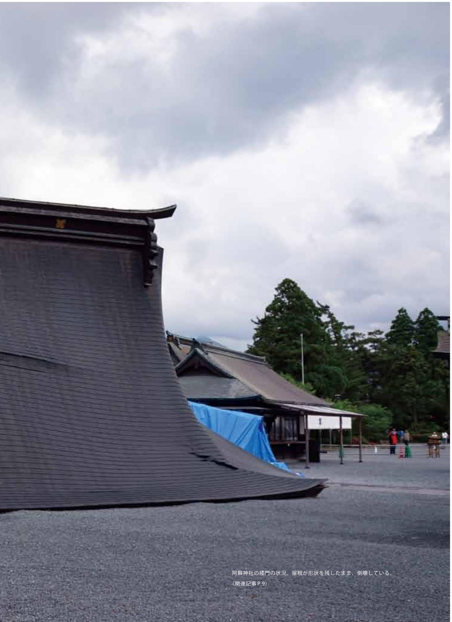
阿蘇神社の楼門の状況。屋根が形状を残したまま、倒壊している。
