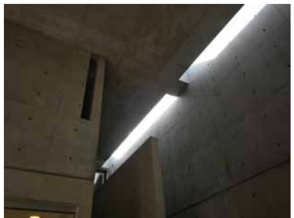
2月27日：旧小篠邸（現KHギャラリー芦屋）（1981/安藤忠雄）。コンクリート打ち放しの壁や天井にスリット状の開口が開けられ、そこから入る自然光が建物内部のさまざまな面を照らす。竣工後、増改築されている。
