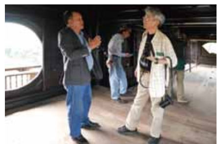
フエの午門（正門）での修復状態調査。ポケットには緑の手帳が入っている。カメラは2台。調査道具は20年以上変わらない（2016年3月）
