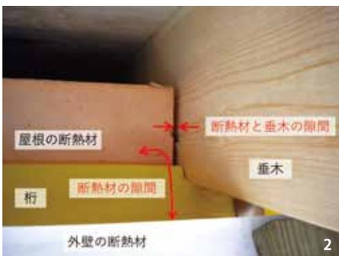
屋根と外壁の接合部。複雑な納まりでも隙間なく断熱材を施工しなくてはならない。
