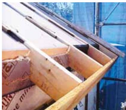
是正工事の途中。断熱材が追加され、発泡ウレタンで隙間を埋め、気密テープで塞いでいる。
