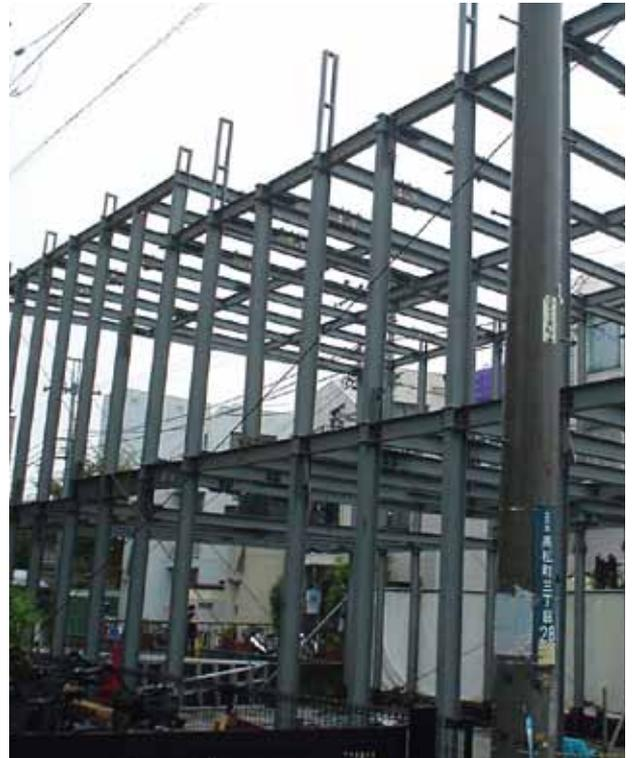
鉄骨造の躯体。柱、梁といった線部材が組みあがる。現場には部材同士がぶつかり合う冷たい金属音が鳴り響いていた。
