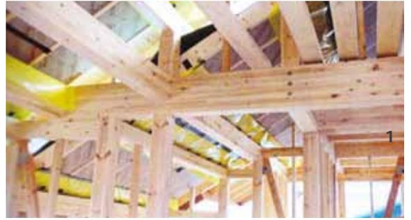
施工中の木造住宅の現場の様子。上棟後、屋根の断熱が施工され、完成後の家の様子が少しずつ見えてくる。
