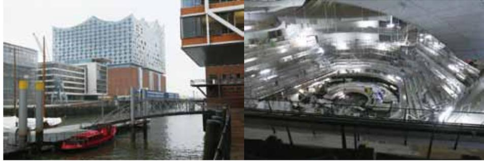
左：エルブフィルハーモニー外観。右：建設現場。壁面の波型は音の拡散をねらっており、音響障害が起きないように、壁によって波型の深さが異なる。
