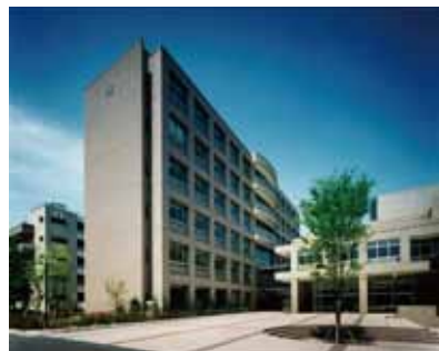
竣工時の教室棟
