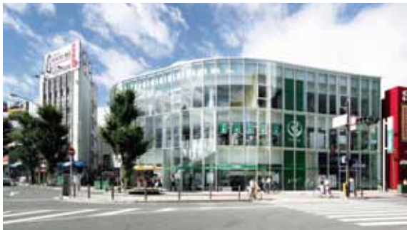
駅前のロータリーに面する銀行が入るオフィスビル。企画から竣工まで携わった最初の作品。
