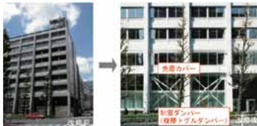
写真4 本郷通りファサードの変容：1～2階に新設した制振ダンパーと、3階に設けた免震装置。免震カバーを極力目立たせない工夫がされている。
