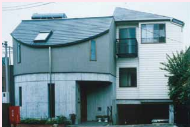
東馬込の家（1992年5月竣工） スキップフロアになっている。私道には花壇のみで堀なしとした。
