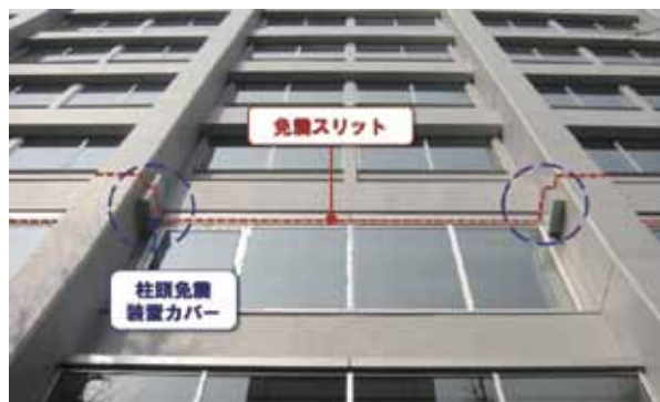
写真5 中間層免震の外観。
