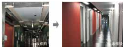
写真3 旧5号館の木造システムパーティションと改修後の研究室階廊下。
