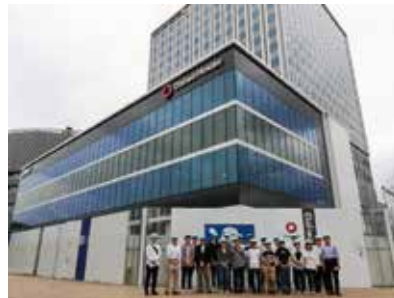
Fコースのテーマは、「特殊設備建設現場 in 豊洲」。(仮称)Dタワー豊洲新築工事現場を先生方の説明とともに見学し、その後、豊洲市場の見学を行った。写真は、工事現場での集合写真。
