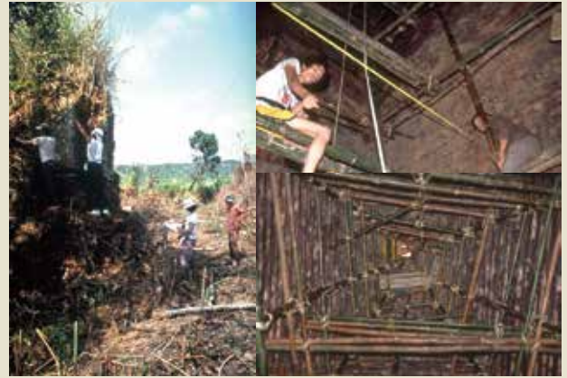
左：ひとりで実測の大変さから手伝ってくれた学生。右上：内部に竹で足場を組んでの実測。右下：この方法は、内部のレンガを観察する良い機会となった。
