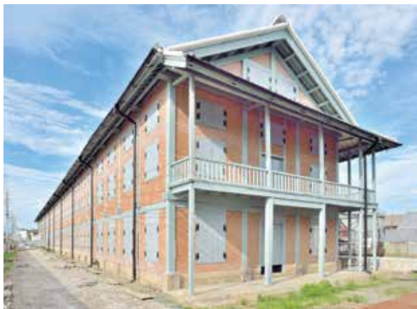
修理のため架けられていた覆い屋が撤去された、竣工間近の西置繭所。
