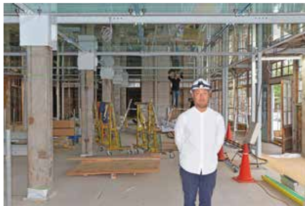
2019年10月現在の西置繭所は、工事も終盤となり、内部の整備が佳境となっている。
