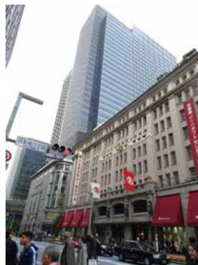
日本橋高島屋の本館（重要文化財・手前）と新館。日本橋二丁目地区市街地再開発事業は開発手法の代表例。重要文化財の雰囲気損なわず地区の更新が図られました。
