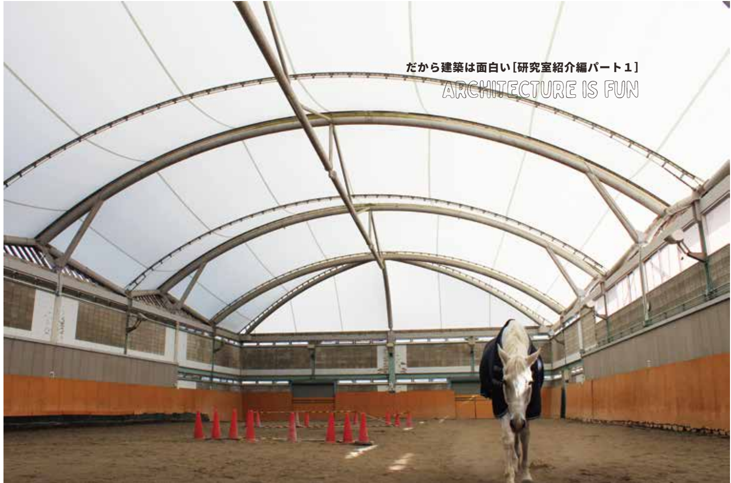
地上積雪が1mでも屋根には雪が積もらなかったという徹底した屋根雪処理された膜構造（室内練習場）。
